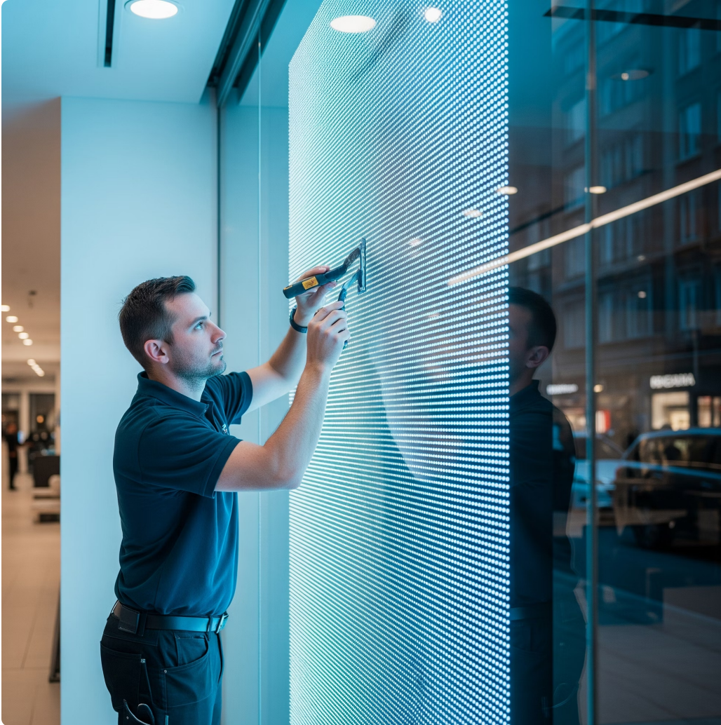
Präzise Inneninstallation direkt auf der Scheibenoberfläche
